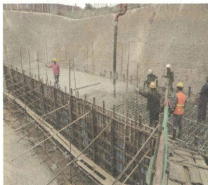
房山区良乡赤尾河综合管廊
