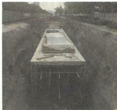
宝鸡市陈仓区南环路综合管廊
